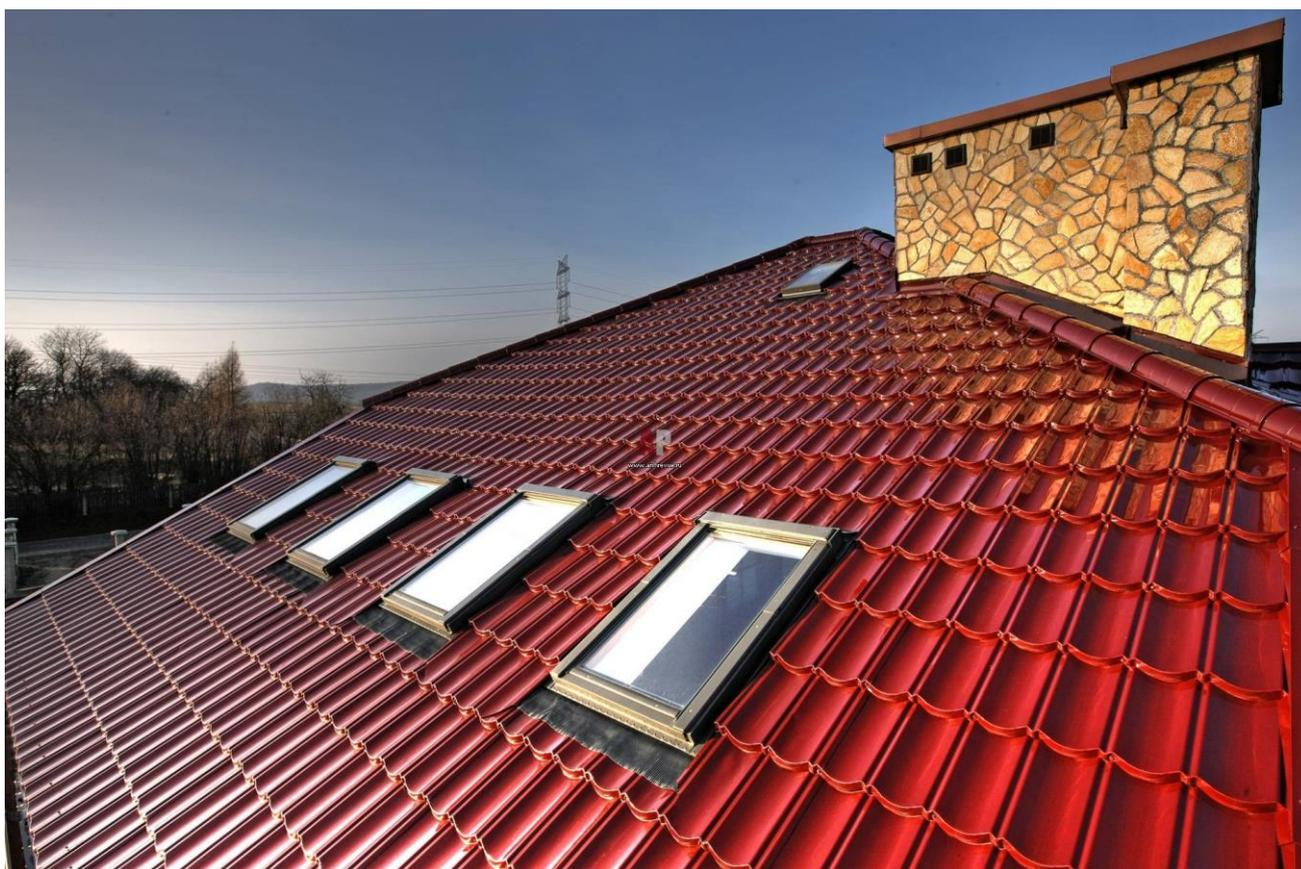
Металлочерепица различается покрытием, толщиной стали и профилем. Толщина стали колеблется в основном от 0,4 до 0,5 мм. Чем толще, тем лучше. Сталь 0,4 слишком тонкая, и это затрудняет монтаж, т.к. большие листы гнутся и сминаются как фольга. Долговечность этого материала напрямую зависит от качества покрытия и качества оцинковки стального листа. Существует возможность как купить листы стандартных размеров, так и заказать листы нужного вам размера.
