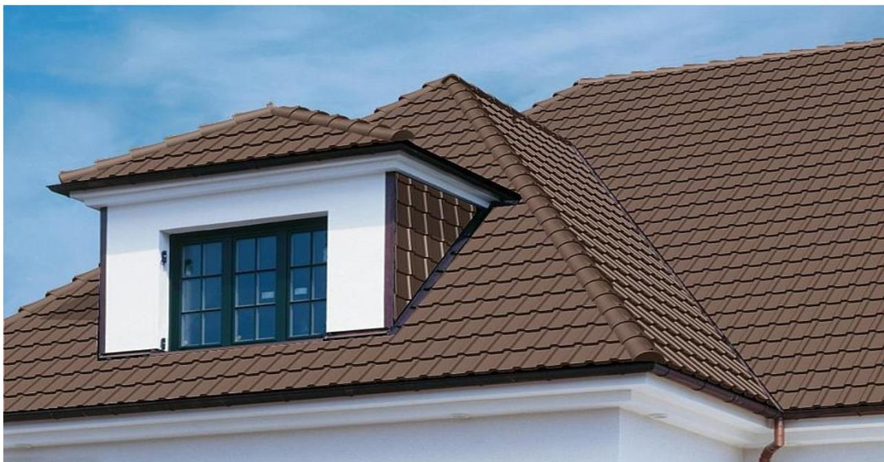
Если халатно отнестись к сборке обрешетки, плитки могут полопаться, так как не выдерживают деформации на изгиб. С другой стороны, именно благодаря массе, пазам, боковому замку и особому рельефу на тыльной стороне, не требуется отдельно фиксировать каждую плитку, прикручиваются элементы по периметру ската, а общая масса лежит на обрешетке свободно.
